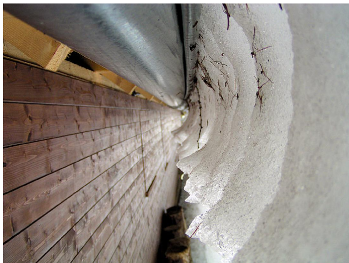
Sníh obtéká okap
